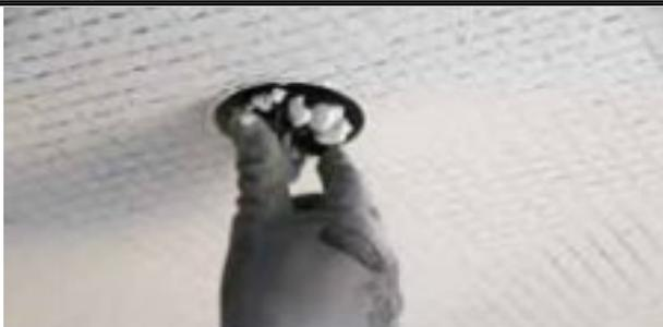
5. Posa di intonaco-rasante traspirante universale certificato di pura calce naturale NHL e tipo Geolegante<sup>®</sup>. Classe di resistenza a compressione CS IV secondo EN 998-1. Idrofugato, specifico come rasante-intonaco di livellamento di superfici assorbenti o rivestimenti sintetici nel risanamento di edifici.
