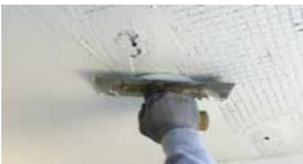
Stesura finale di pittura organica minerale eco-compatibile, a base di resine stiroloacriliche all'acqua, lavabile, resistente alle muffe.
