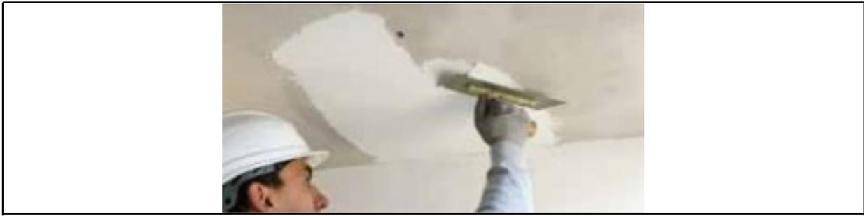
3. Posa di rete tipo GeoSteel Grid 120, rete biassiale bilanciata in fibra di basalto, con speciale trattamento protettivo alcali-resistente con resina all'acqua priva di solventi, termofissati fra di loro al fine di garantire un tessuto stabile in entrambe le direzioni e di facile applicazione, installabile a scelta con matrici della famiglia tipo GeoCalce<sup>®</sup>, GeoLite<sup>®</sup> o GeoLite<sup>®</sup> Gel, e secondo le modalità/stesura previste nell'elaborato di progetto
