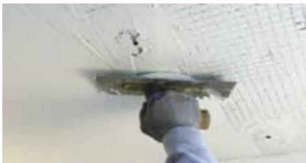
Stesura finale di pittura organica minerale eco-compatibile, a base di resine stiroloacriliche all'acqua, lavabile, resistente alle muffe.
